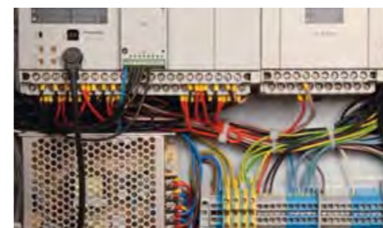
Costruzione di cassette di comando incl. PLC per automazione
